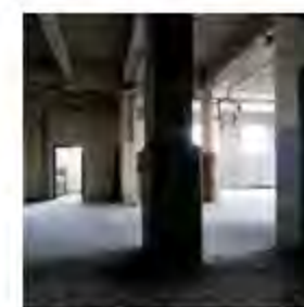
14. Betonski stebri in betonske grede
