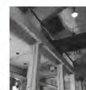
12. Betonski stebri in betonske grede
