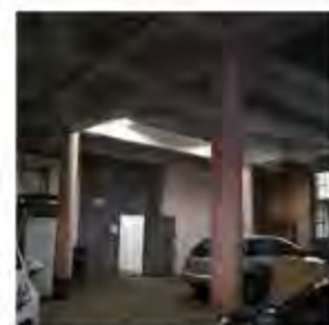
1. Betonski stebri in betonske grede
