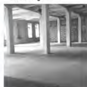
8. Betonski stebri in betonske grede
