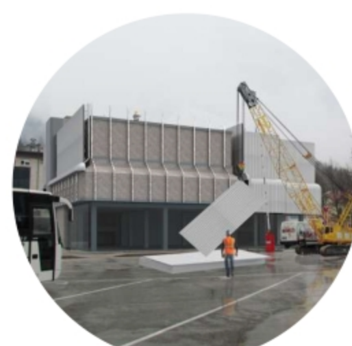
Fasada se previdno razstavi in sanira, moteče elemente pa se odstrani
