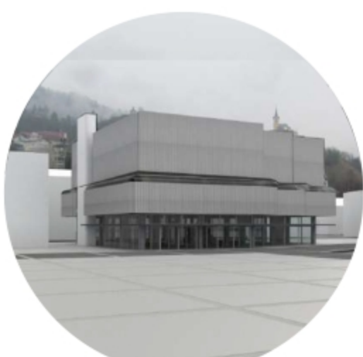
Prenovljen objekt ohranja prvotno podobo Kerševanove zasnove
