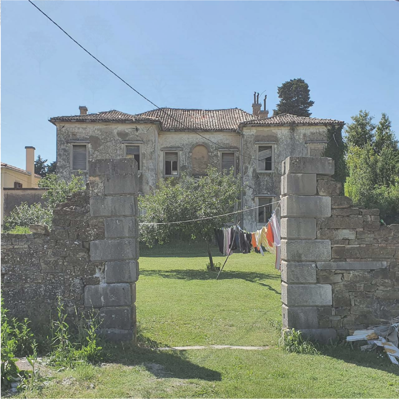
Fotografija_pogled skozi vzhodni portal
