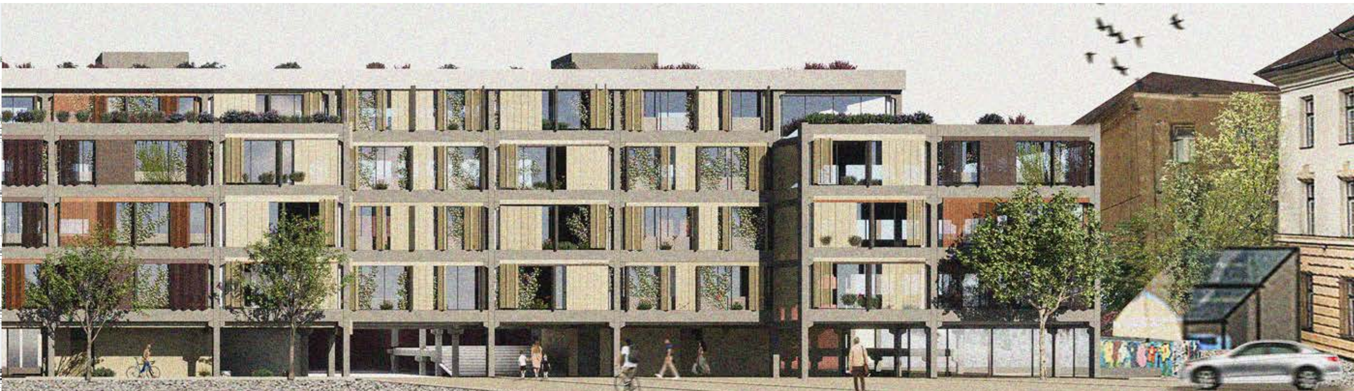
Preprosto betonsko konstrukcijo zapirajo kovinski senčni paneli, ki se usklajujejo z barvno paleto okolice.
