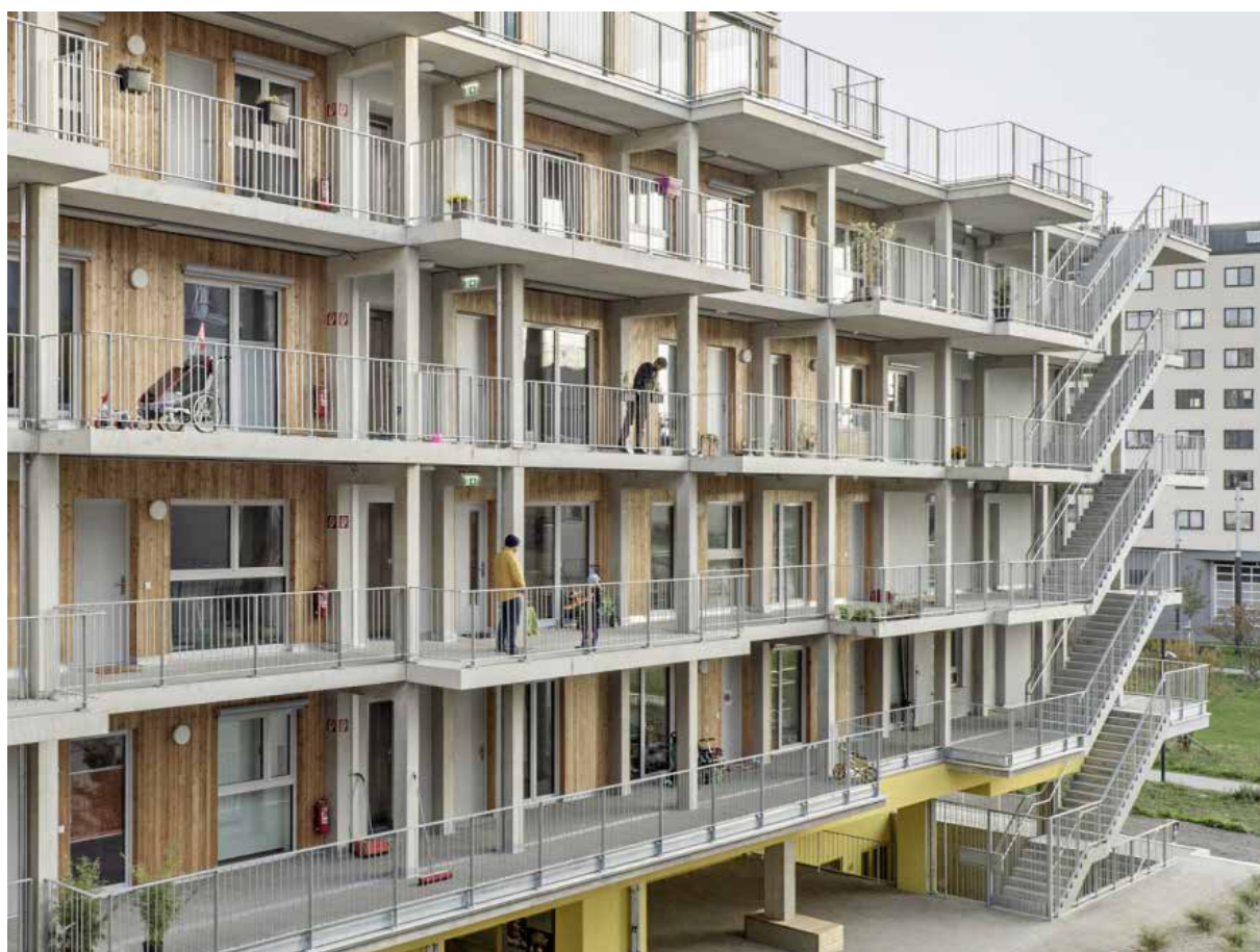
Z: Stavba - pogled iz parka (vir: www.miesarch.com , © Hertha Hurnaus) S: Zunanje stopnišče z dostopi do stanovanj (vir: www.miesarch.com , © Hertha Hurnaus)
