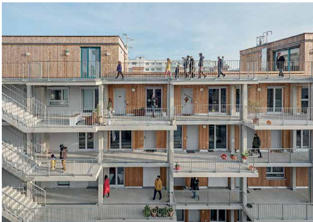
Z: Gank in dostopi do stanovanj (vir: www.gleis21.wien ) S: Odprte stopnice in ganki, razširitve (vir: www.gleis21.wien , © Hertha Hurnaus)
