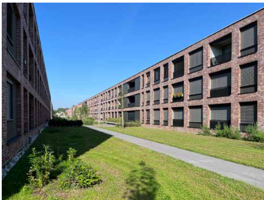
Z: Večnamenska stavba in skupnostni prostor S: Pogled z vzhodnega dela zazidave L: Pogled s sredine dvorišča med bloki
