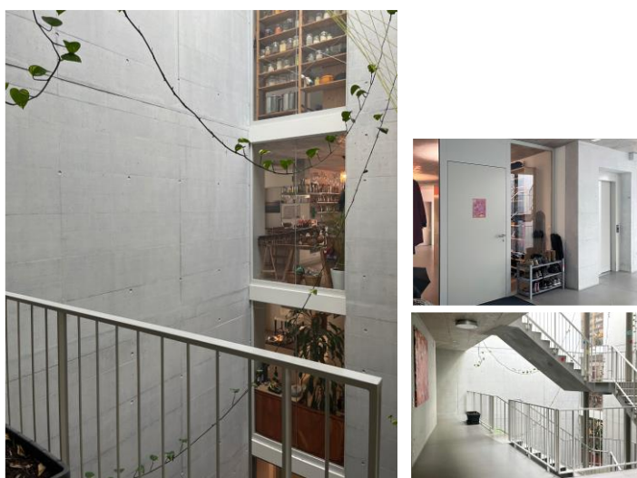
Okna skupnostnih stanovanj, ki se odpirajo na stopnišče Mehr als Wohnen, Hunziker Areal
