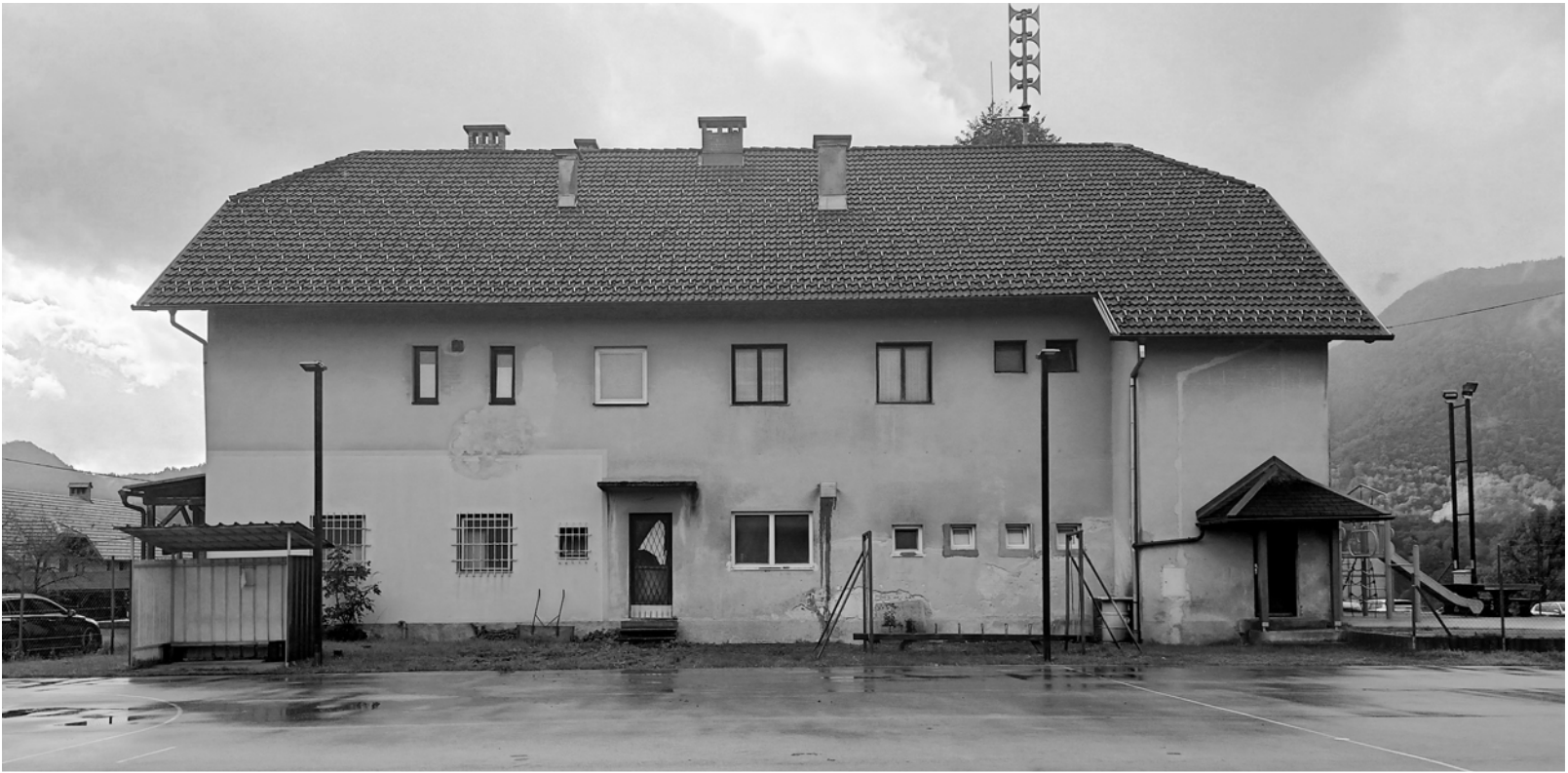
Obstoječe stanje - severna fasada
