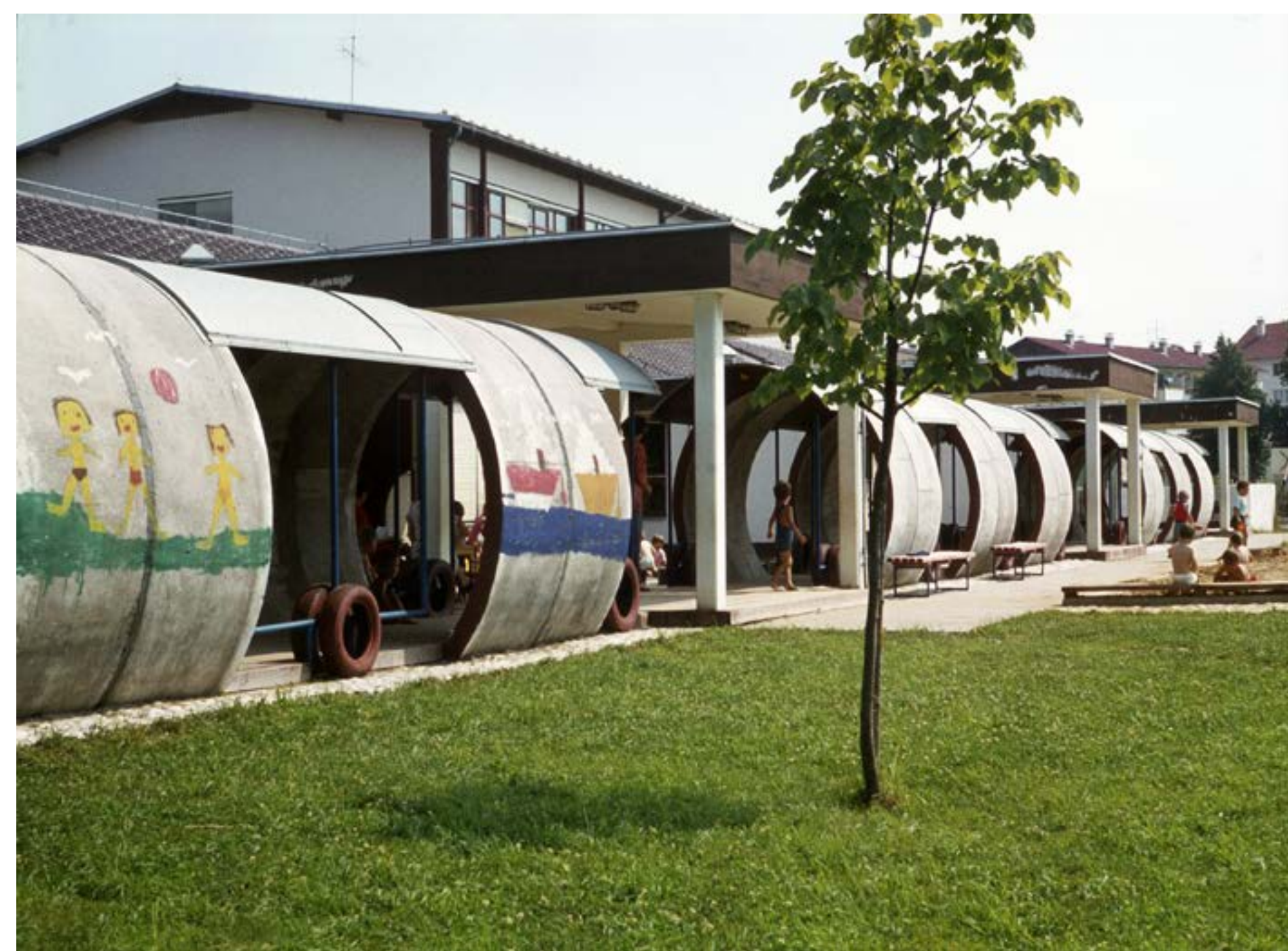
Uporaba prefabricirane cevi pri vhodu vrtca Logatec © Rotija Badjura (Galerija DESSA)
