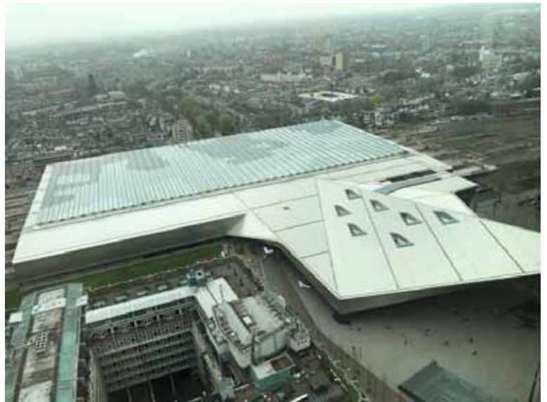
Slika 3: Hladna streha z visoko odbojnostjo in emisivnostjo na glavni železniški postaji, Rotterdam
