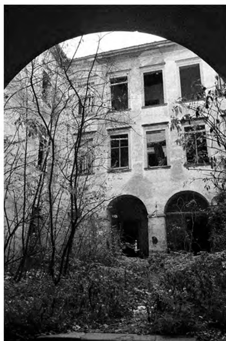
pregled na južno dvoriščno bazo
