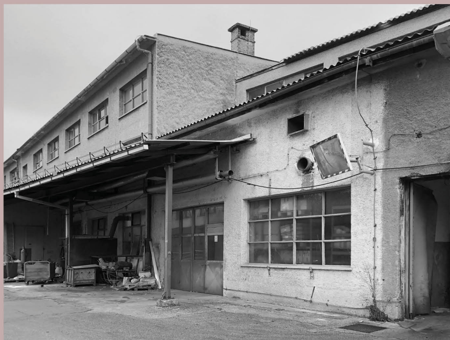
Pogled na stik Objekta A1 in Objekta A2 z južne strani.
