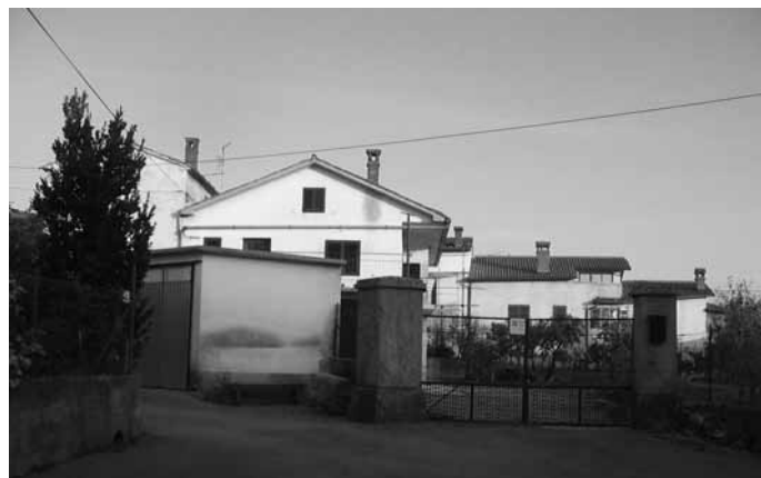
Slika 2: Po drugi svetovni vojni so portala uničili in vgradili železen porton. (Foto: Jasna Fakin Bajec, 2004.)
