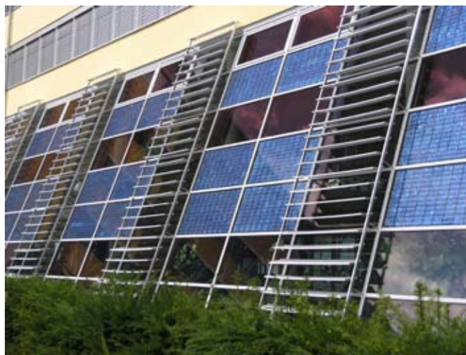
Slika 8: Sončni moduli na fasadnem ovoju objekta [foto: Zbašnik-Senegačnik, 2006].
