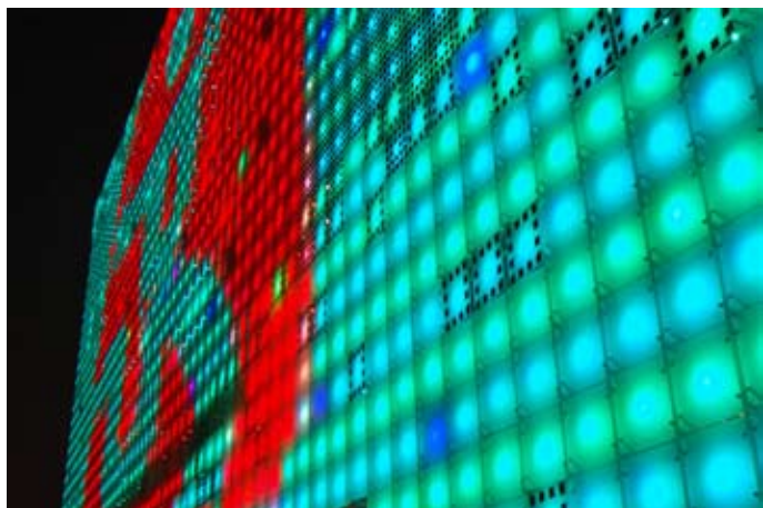
Slika 9: Medijska fasada - sončne celice podnevi pretvarjajo energijo iz sončne v električno, ki jo ponoči LED zaslon uporablja za osvetlitev [http://www.greenpix.org/<9.3.2009>].
