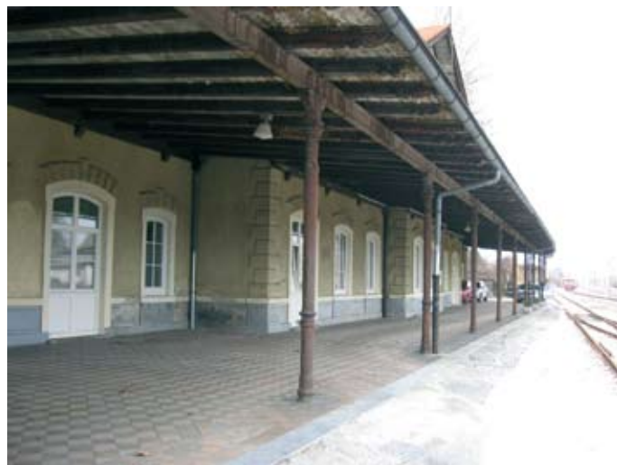
Slika 2: Litoželezni stebri in nosilec na železniški postaji v Spodnji Šiški v Ljubljani
