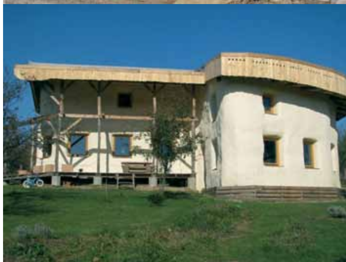
Slika 7: Tudi v Sloveniji je že nekaj objektov grajenih s slamnatimi balami. V obeh predstavljenih primerih gre za sistem lesene skeletne konstrukcije s polnilom slamnatih bal. Levo hiša na Kureščku [vir: http://www.soustvarjanje.si], desno hiša v Čikečki vasi [foto: Kristijan Zver].
