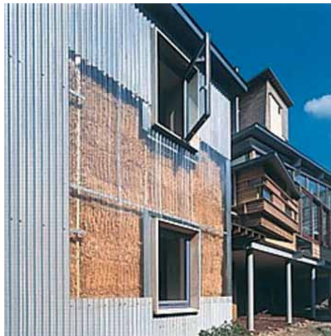
Slika 5: Stanovanjski objekt v Londonu. [vir: http://www.swarch.co.uk/].
