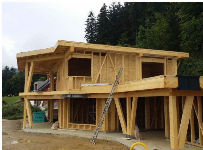
Pasivna hiša MISLINJA (Koroška)
