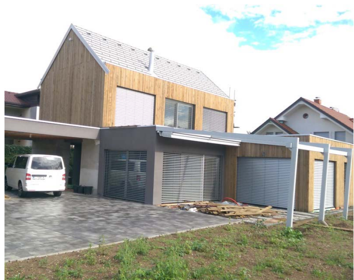
Pasivna hiša MISLINJA (Koroška)
