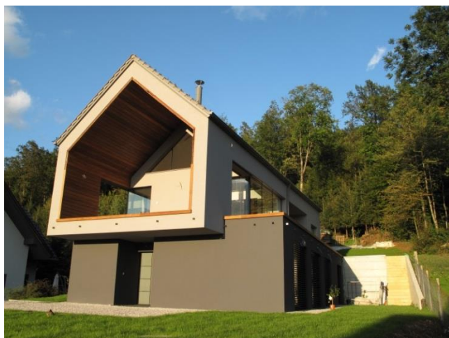
Pasivna hiša Tupaliče pri Kranju
