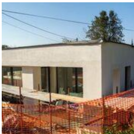
Pasivna hiša Sostro
