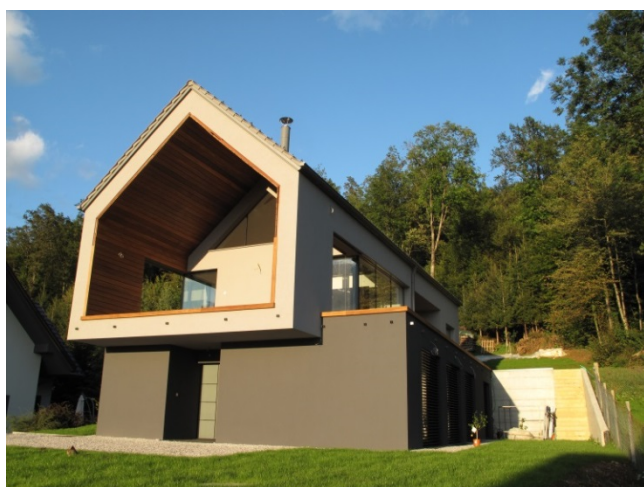
Pasivna hiša Tupaliče pri Kranju
