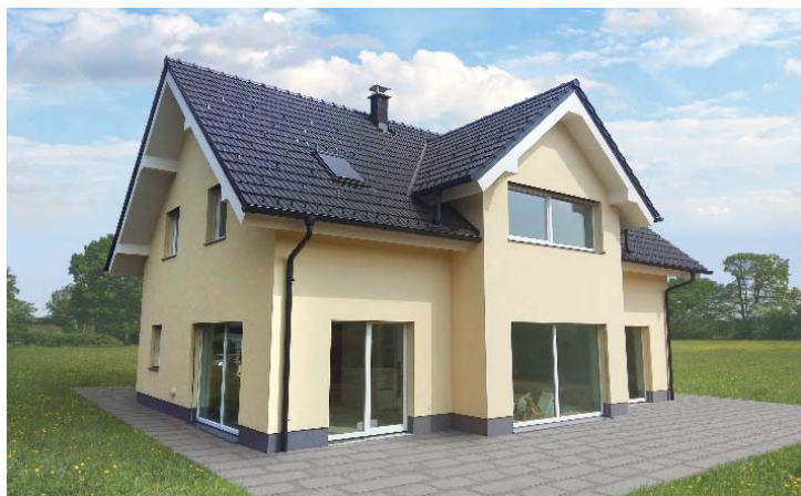
Pasivna hiša, Hiša 174, Kranj
