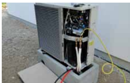
Zunanja enota toplotne črpalke z uparjalnikom za odvzem toplote iz okolice (v našem primeru zrak), v katerem se delovna snov (hladilo) pri nizki temperaturi upari in s egreje s toploto iz okolice.
