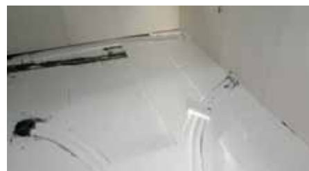
Cevi za prezračevanje so položene v plast zvočne izolacije.
