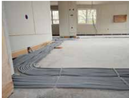
Montaži hiše sledi najprej razvod vodovodnih in električnih instalacij, ki potekajo po plošči
