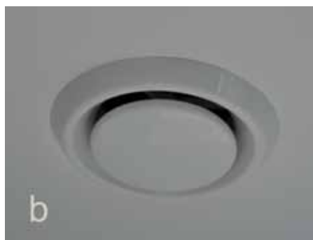
Difuzor za dovod svežega zraka v »čiste« prostore - dnevna soba, spalnice in otroške sobe (a) in difuzor za dovod zraka iz »umazanih« prostorov - kuhinja, kopalnica, shrambe, tehnični prostori (b)
