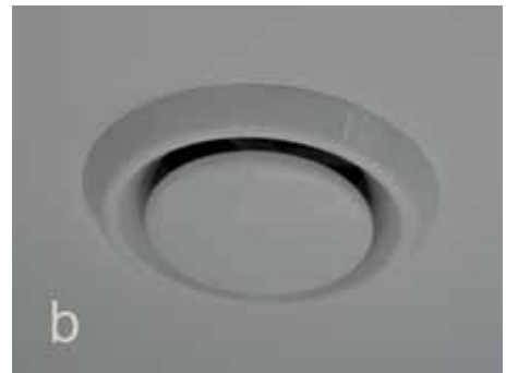
Difuzor za dovod svežega zraka v »čiste« prostore - dnevna soba, spalnice in otroške sobe (a) in difuzor za dovod zraka iz »umazanih« prostorov - kuhinja, kopalnica, shrambe, tehnični prostori (b)
