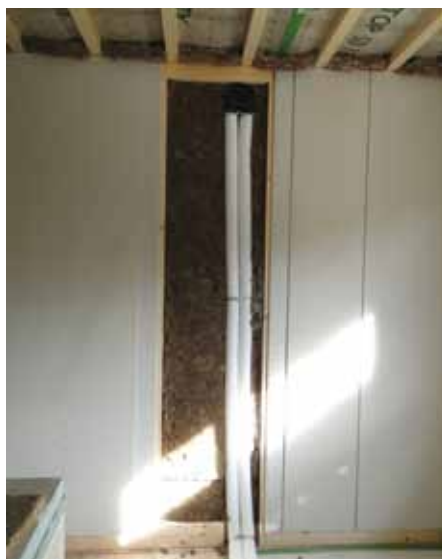
Sveži zrak se v zgornje prostore dovaja preko difuzorjev na stenah.
