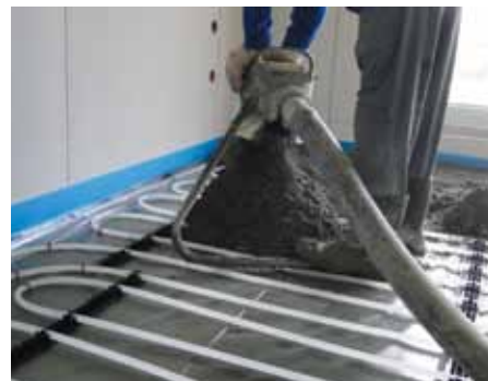
Strojna vgradnja estriha na cevi talnega ogrevanja
