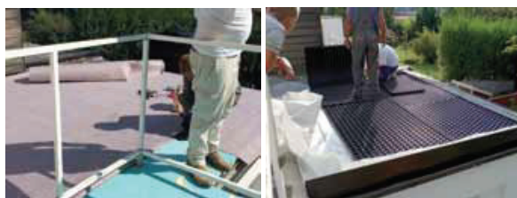
FIBRANfilter – sloj geotekstila je položen pod čepasto folijo, ki sicer služi zadrževanju vode na predelu ozelenjene terase.
