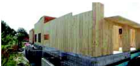
Slika 1-3 Vrtec Otona Župančiča, enota Čebelica: uporaba lesa kot osrednjega elementa novogradnje Arhitektura in foto: Marko Potisek, 2014
