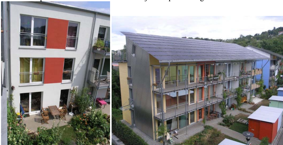
Slika 1: V pasivni hiši so okenske površine večje, saj omogočajo dobitke sončnega sevanja
