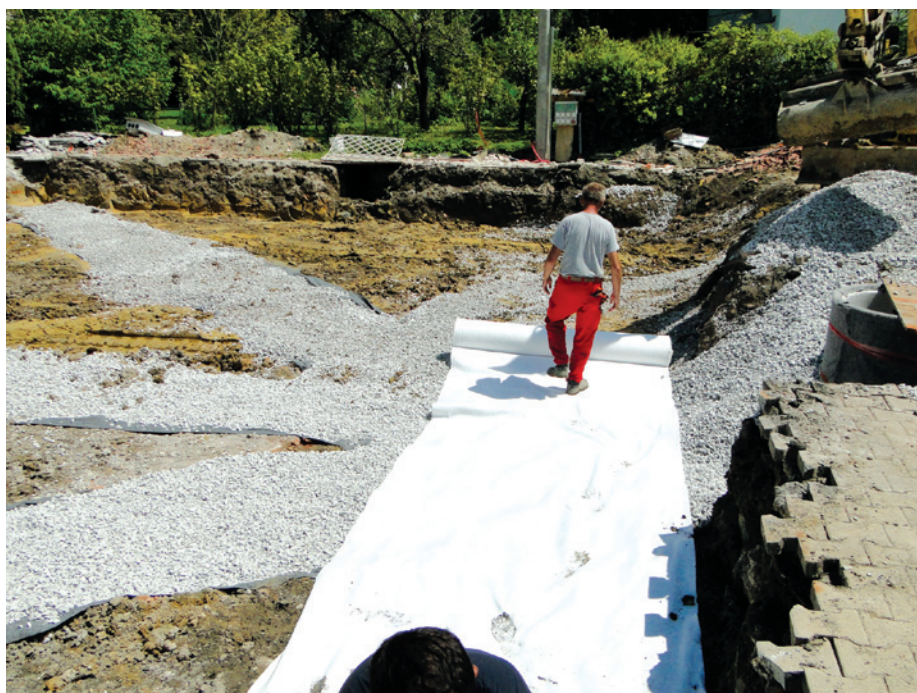
9. Polaganje geotekstila na teren za preprečevanje pogrezanja granulata v ilovico
