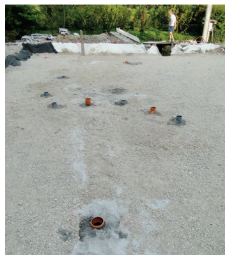
16. Instalcijske cevi, vgrajene v utrjeno podlago
