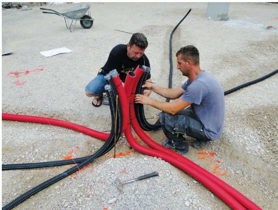
15. Polaganje cevi za elektriko in komunikacije v utrjeno nasutje
