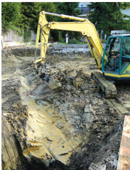
5. Izkop drenažnih kanalov
