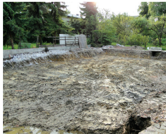
3. Izkopan teren je pripravljen za utrjevanje
