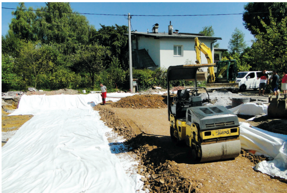
10. Teptanje prve plasti nasutja, cca 35 cm, granulacija 0–100 mm
