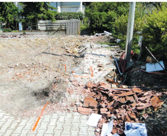
1. Zakoličba temeljne plošče pred izkopom
