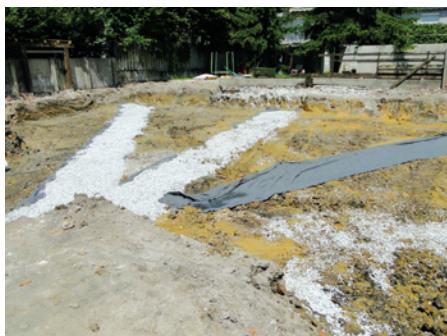
6. Drenažni kanali – gramoz na geotekstilu
