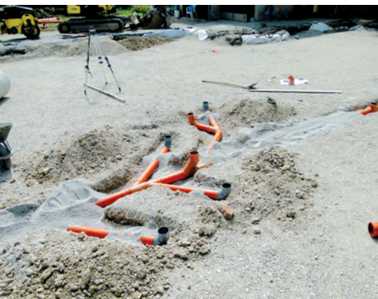
14. Polaganje kanalizacijskih cevi v utrjeno nasutje
