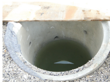
8. Voda se v betonskem jašku nabere takoj po padavinah, drenažni kanali torej dobro delujejo
