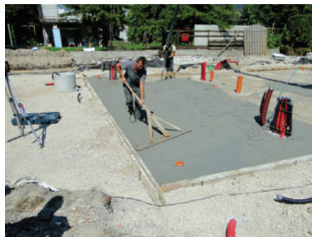
3: Vlivanje podložnega betona na utrjeno podlago
