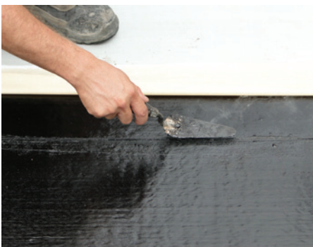
7: Bitumenski trakovi hidroizolacije se med seboj prekrivajo, na stiku se bitumen zmehta s toplim zrakom in zagladi.
