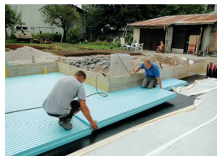
11: Polaganje druge plasti FIBRANxps SEISMIC 400-L, ki ima na zgornji površini utore za boljše oprijemanje betona
