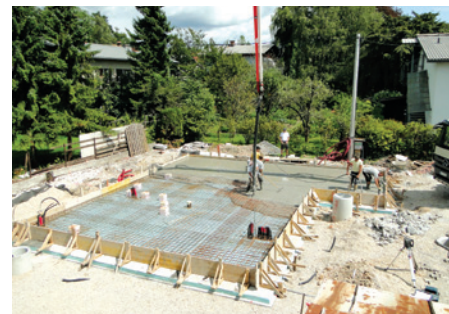
16: Vlivanje betona za temeljno ploščo
