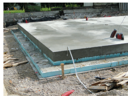
17: Razopažena temeljna plošča
