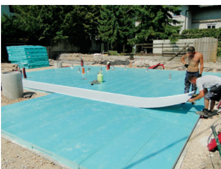
6: Polaganje hidroizolacije FIBRANhydro Seismic pravokotno na plošče toplotne izolacije FIBRANxps
