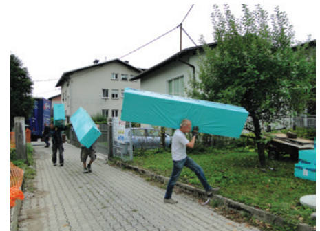
4: Dostava materiala za Seismic temeljno blazino
