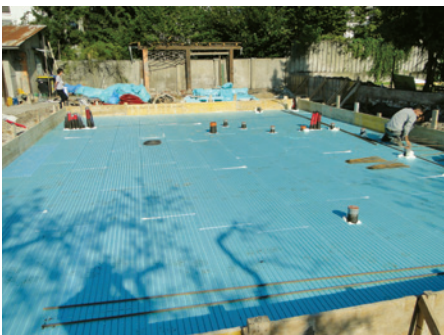
13: Zaključeno polaganje druge plasti FIBRANxps SEISMIC 400-L
