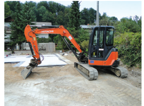
23: Poravnava terena z nasutjem okrog Seismic temeljne blazine
