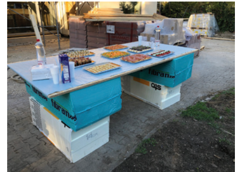
24: Zavoji toplotne izolacije FIBRANxps so primerni tudi kot podstavek za priložnostno zakusko ob zaključku ene od gradbenih faz.
