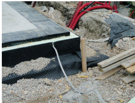
22: Na XPS smo dodatno položili čepasto folijo, ki poskrbi, da voda ne zastaja ob stavbi.
