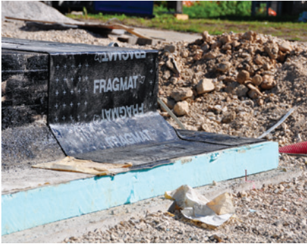
20: Vertikalna hidroizolacija ob AB plošči se spoji s horizontalno na prvi plasti XPS-a.
