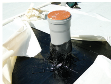
9: Vse instalacijske cevi se oblepi s hidroizolacijo
