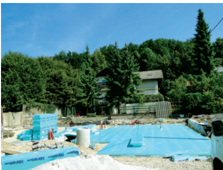
5: Polaganje prve plasti toplotne izolacije FIBRANxps 400-L
