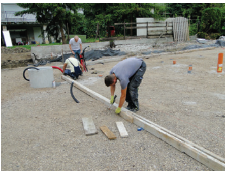
2: Izdelava opaža za podložni beton
