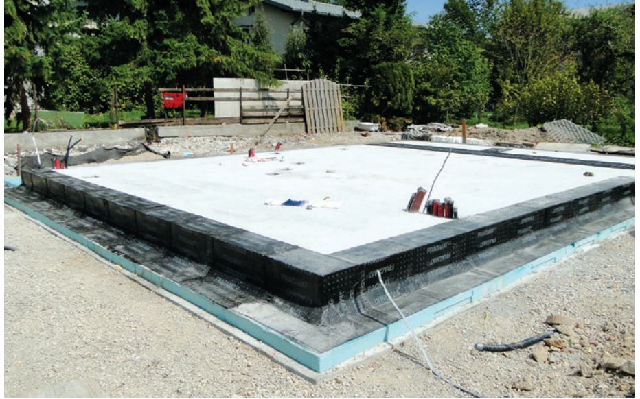
21: Seismic temeljna blazina s položeno vertikalno hidroizolacijo
