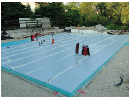
8: Trakovi hidroizolacije popolnoma prekrijejo prvo plast FIBRANxps 400-L.
