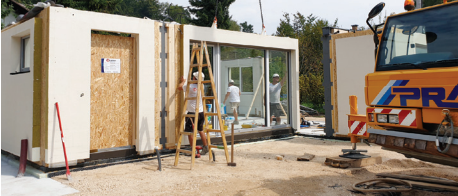
Montaža stenskih elementov na temeljno ploščo
