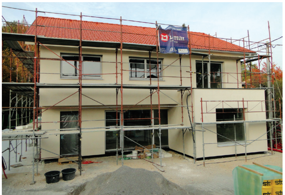
Temeljni nanos tankoslojnega ometa na fasadi
