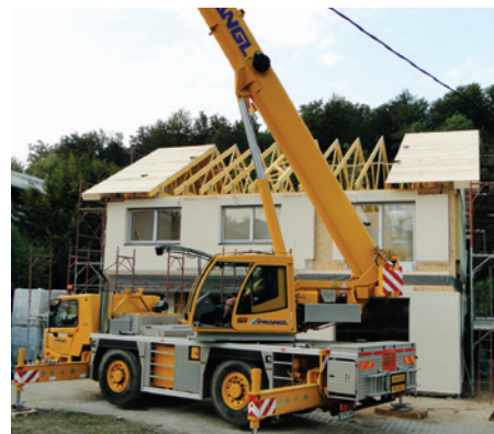
Pasivna hiša je dobila strešno konstrukcijo iz žebeljanih nosilcev
