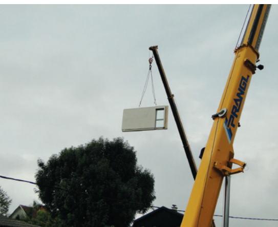
Dvigovanje konstrukcijskih elementov z avtodvigali s kamiona na ulici preko okoliških preprek na gradbišče
