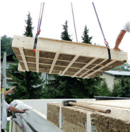
Polaganje elementa medetažne konstrukcije na steno prve etaže
