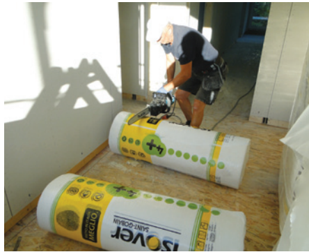
Razrez steklene volne pred vgradnjo med žebeljane nosilce
