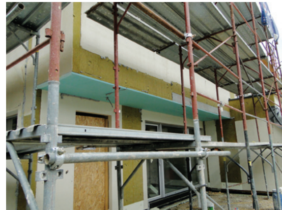
Toplotna izolacija XPS na spodnji površini previsa
