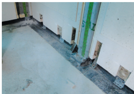
Pasivna hiša je s kovinskimi sidri pritrjena na temeljno ploščo
