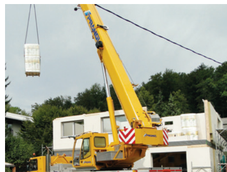
Transport toplotne izolacije na hišo
