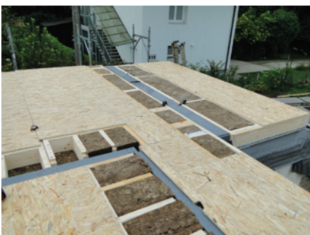
Kovinske ojačitve (sivi nosilci) in zvočna izolacija med stropniki medetažne plošče
