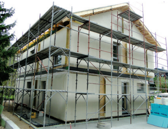
Stenski elementi že v delavnici dobijo temeljni nanos tankoslojnega ometa, na montažnih stikih je še vidna plošča OSB
