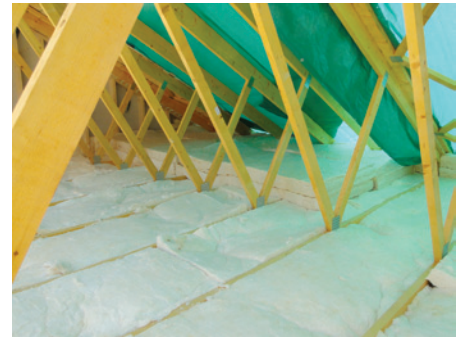
Polaganje 50 cm steklene volne Isover, \lambda = 0,032 \text{ W/(mK)} , med žebeljane nosilce strešne konstrukcije, U = 0,068 \text{ W/(m}^2\text{K)}
