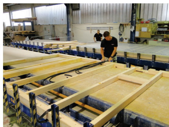
7: V montažnih elementih so že vgrajene električne, vodovodne in kanalizacijske cevi.
