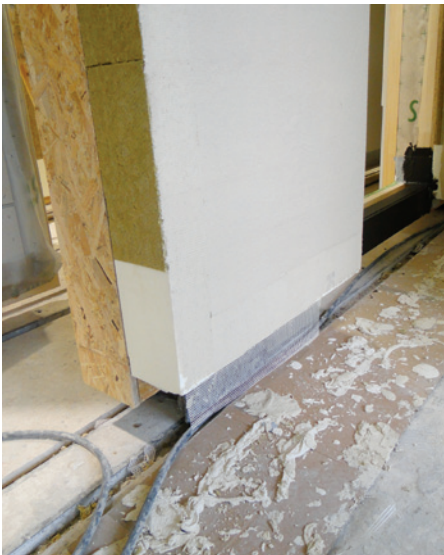
11: Zunanja stena s fasadno toplotno izolacijo z kamene volne, na podstavku iz XPS, že v delavnici dobi temeljni nanos ometa.
