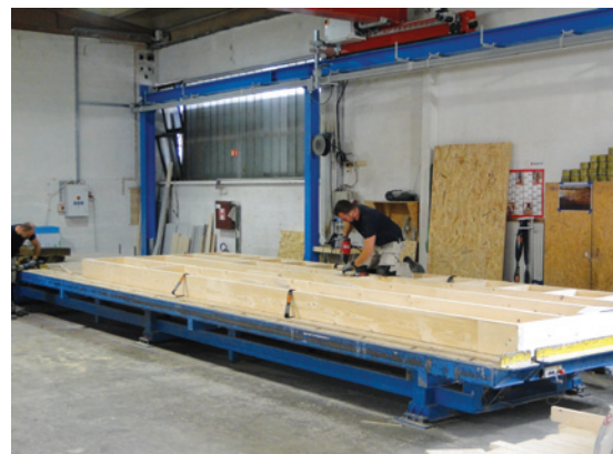
6: Sestavljanje nosilnega ogrodja montažnega elementa na delovni mizi
