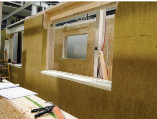
10: Pogled na zunanji stenski element s fasadno toplotno izolacijo iz kamene volne
