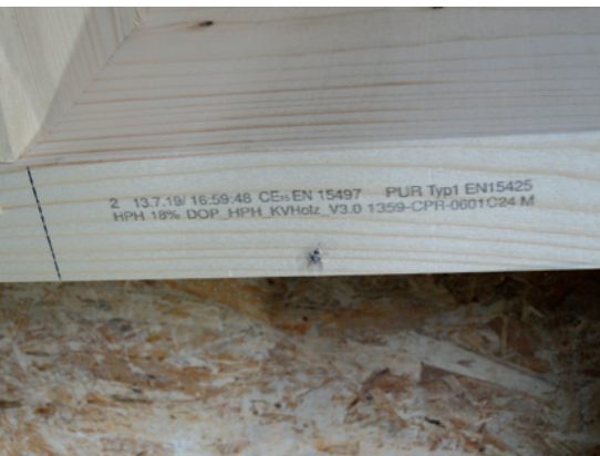
2: Za izdelavo montažne hiše je izbran masivni smrekov les ustreznе kakovosti, ki mora biti evidentirana.
