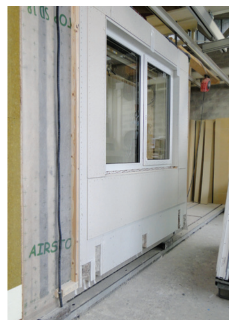
13: Pogled na notranjo stran stenskega elementa z vidno parno oviro in utori za sidra, s katerimi se objekt sidra na temeljno ploščo
