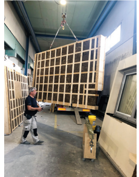
15: Nalaganje montažnih elementov na tovornjak
