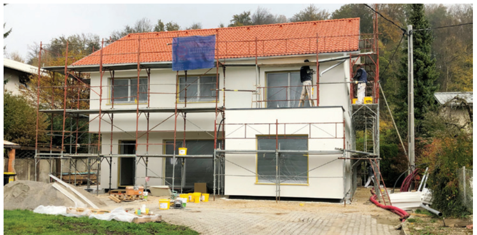
Gradnja pasivne hiše v Rožni dolini
