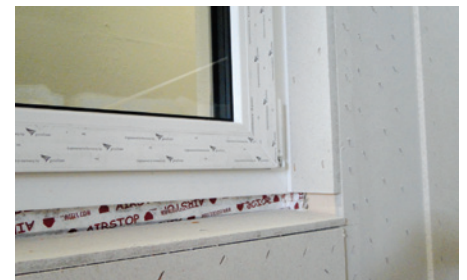
Zrakotesna vgradnja okna
