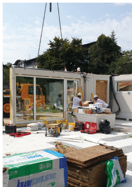
Montaža pasivne hiše na Seismic temeljno blazino
