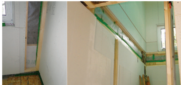
Zrakotesna parna ovira je vgrajena v stenske elemente že v delavnici, na gradbišču se folijo sosednjih elementov zlepi med seboj.
