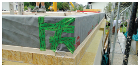
Zrakotesna folija na zanjem robu medetažne konstrukcije – z notranje strani bo nalepljena na parni oviri v stenskih konstrukcijah pritličja in nadstropja.
