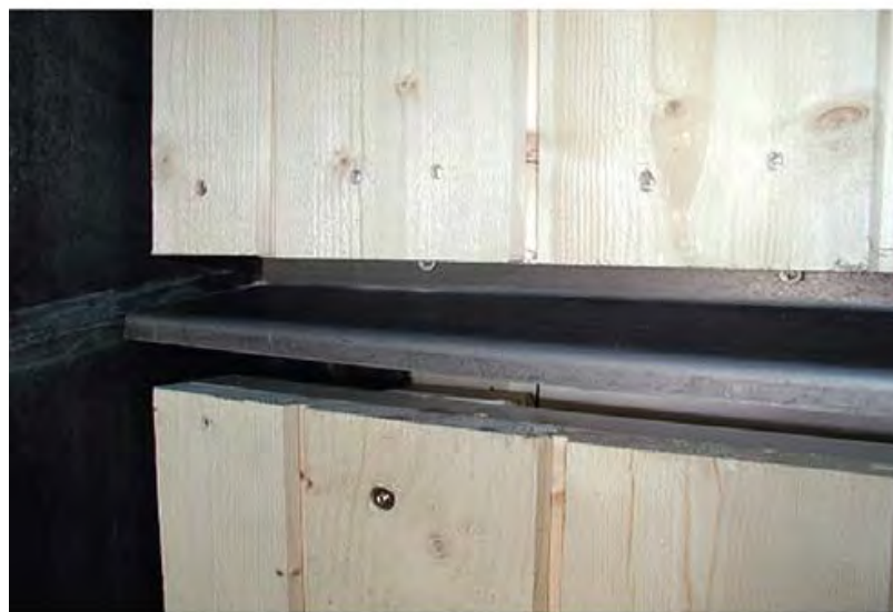
Risba 3: Primer zaščite, ki določen čas preprečuje vertikalni prenos požara po leseni fasadi (Vir: FASSADEN AUS HOLZ, GVZ)
