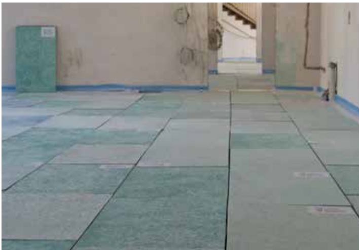
Vakuumdämmung / Vacuum insulation panels
