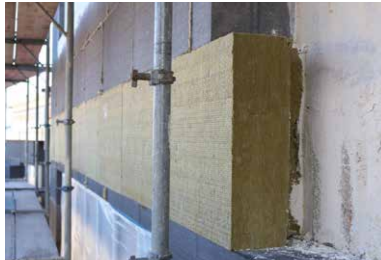
Erhöhter Brandschutz durch Brandriegel aus Mineralwolle Stonewool fire barrier slabs for added fire protection
