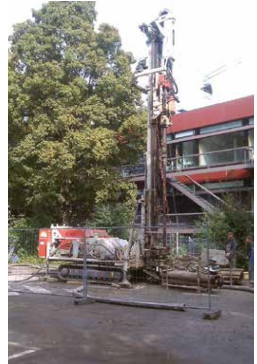
Erdsondenbohrung Geothermal borehole drilling
