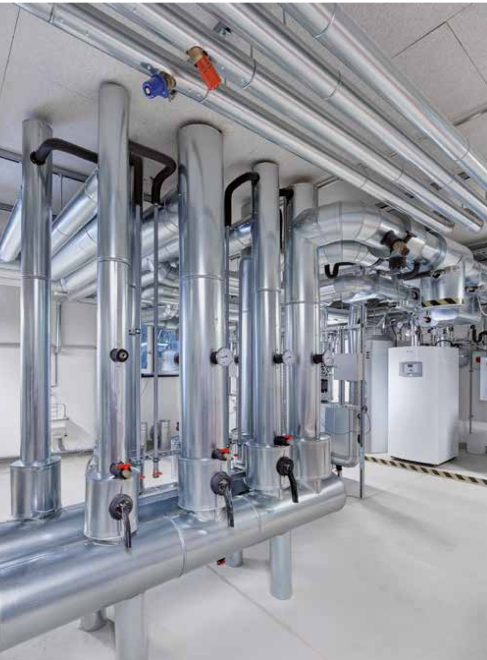
Wärmepumpe mit Verteilsystem Heat pump with distribution system
