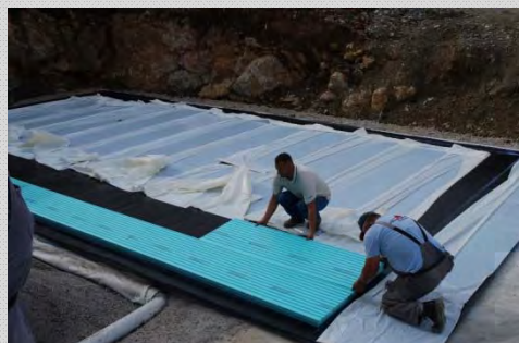
SEISMIC temeljna blazina
